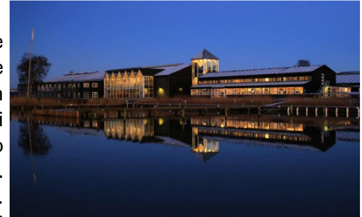
Sede del cantiere X-YACHTS a Haderslev - Danimarca
